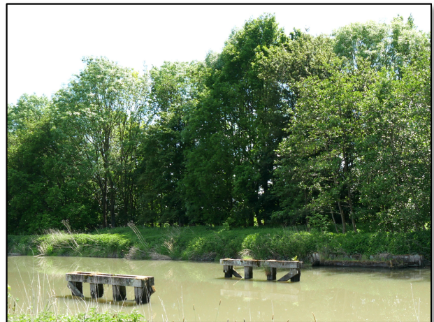
Abb. 5: Ufer und Brückenrest am Randgraben
