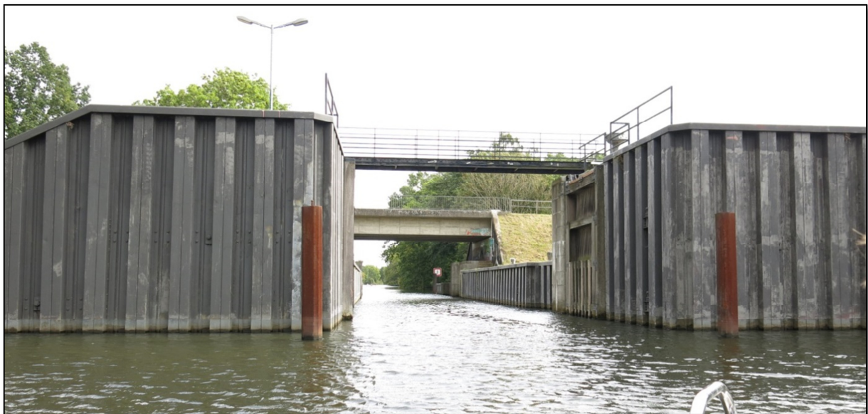
Abb. 13: Außenhaupt der Dove Elbe-Schleuse
